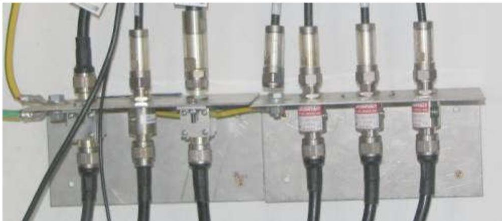
Protection des émetteurs et des récepteurs par des parafoudres coaxiaux, avec écoulement à la terre.
